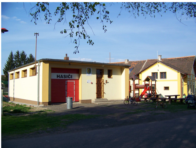
Foto: Při rekonstrukci, byla vyměněna okna, vrata, dveře a kompletně zateplena fasáda
